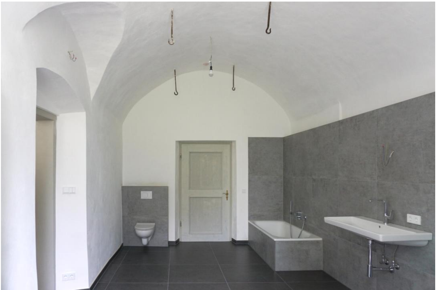
Neues Bad mit Fußbodenheizung
