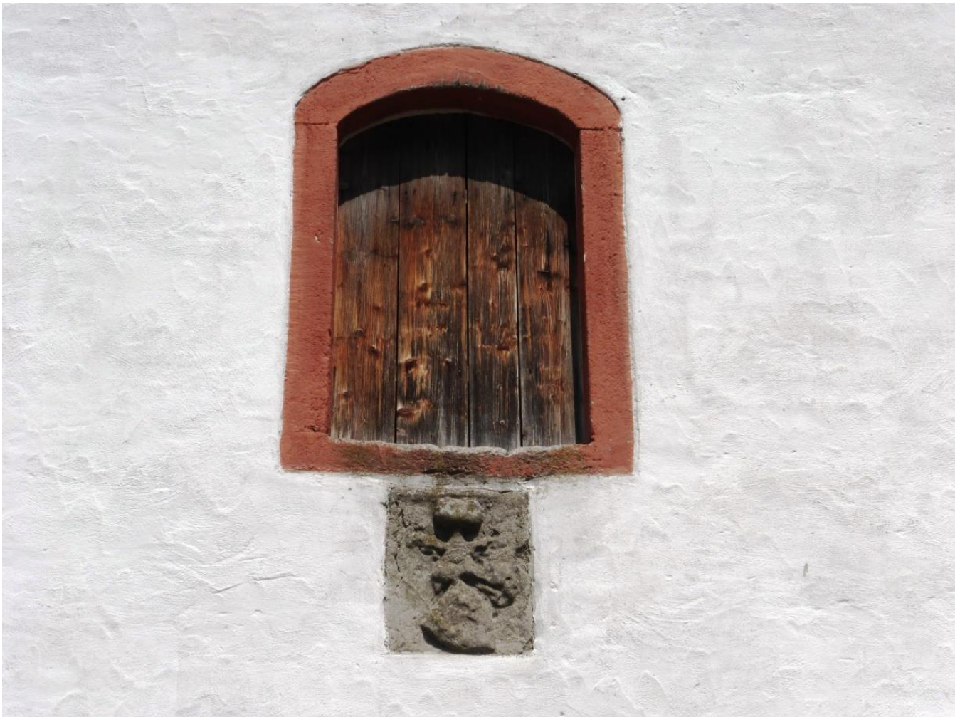
Spätgotisches Seckendorf-Wappen, Innenhof-Fassade NO-Flügel
